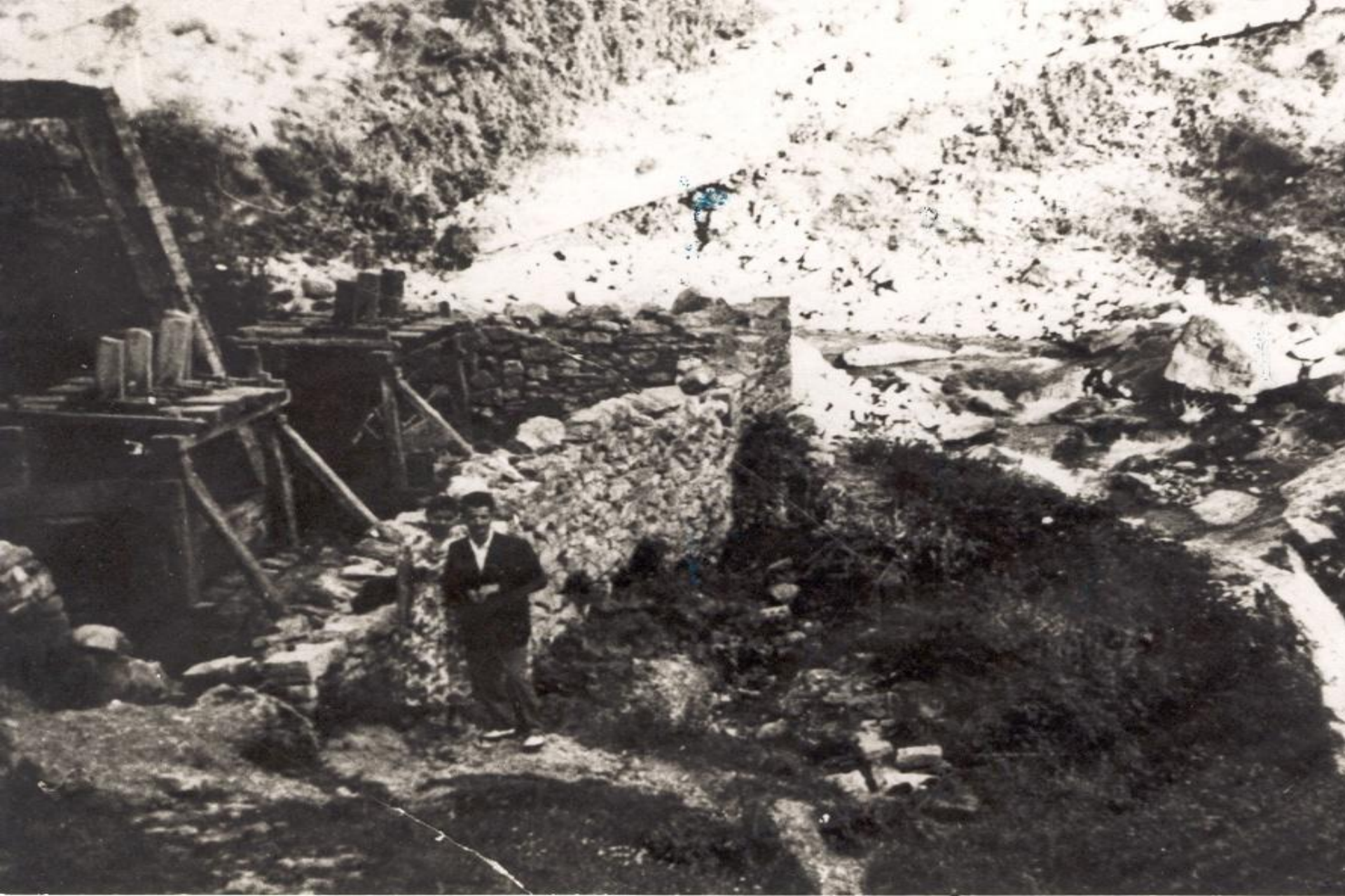
Άποψη των μαντανιών σε πλήρη λειτουργία, δεξιά ο καταρράκτης. Από το φωτογραφικό αρχείο του κ. Δ. Καλούσιου. Λήψη 1957
